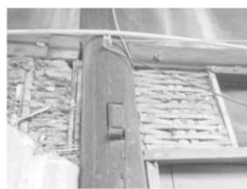
图4 木骨泥墙构筑
